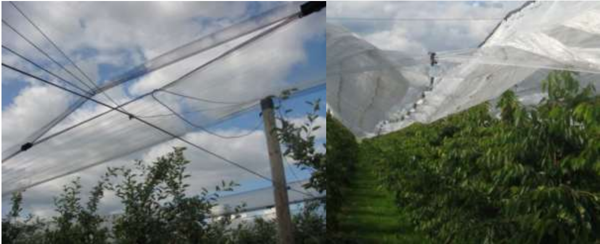
Abb. 6: Offene Bereiche zwischen Netzbahnen (AV, links) und Folienbahnen (KV, rechts)
